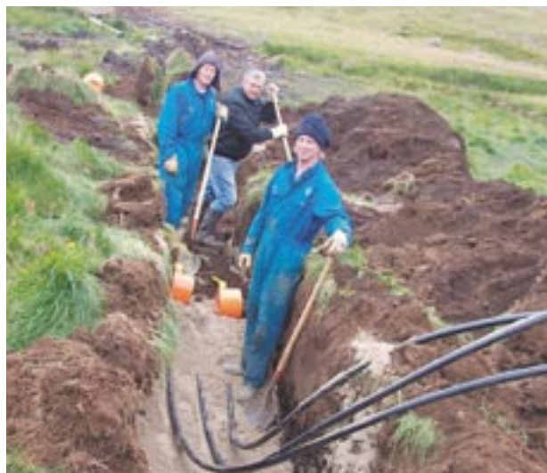
Lagning háspennustrengja í Öfundarfirði.
