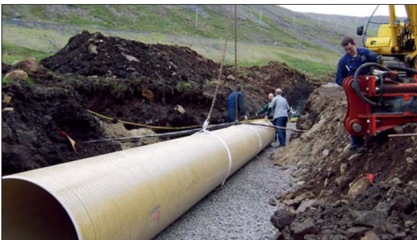
Pípulögn að Tungudalsvirkjun.
