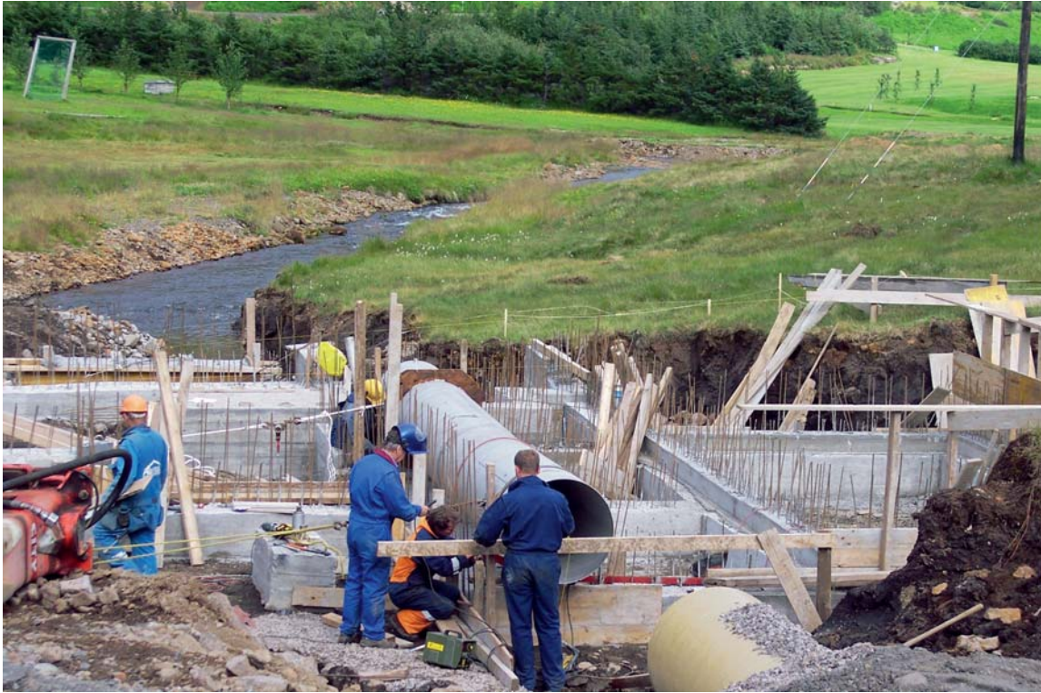
Undirstöður Tungudalsvirkjunar.
