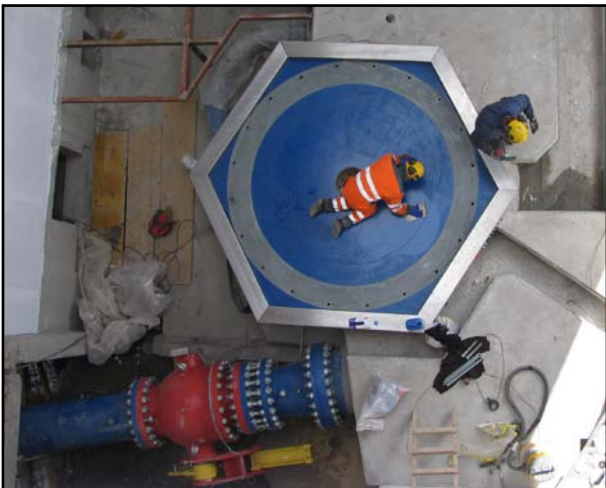
Unnið við sæti rafals á toppi túrbínuhúss.
