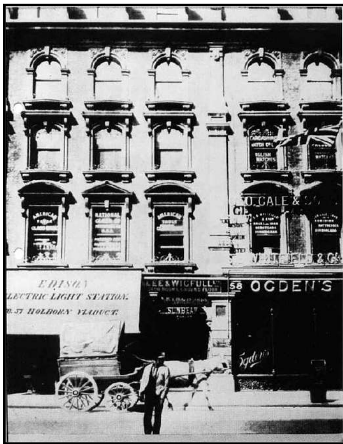
Fyrsta rafstöðin, Holborn Viaduct í London.
