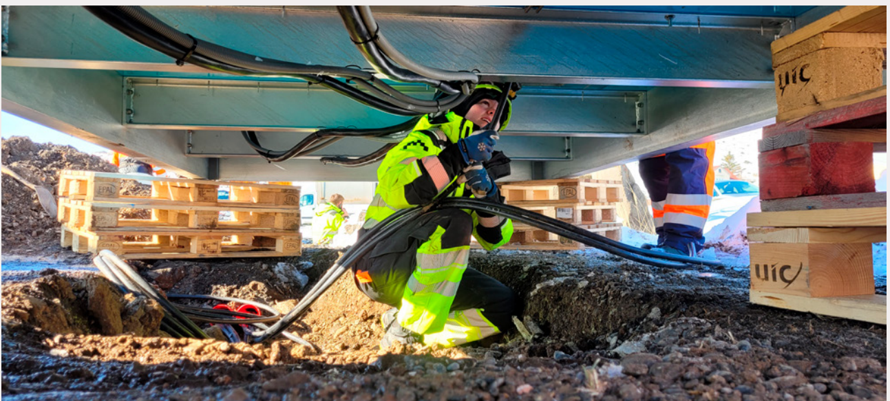
Tenging nýrrar hraðhleðslustöðvar á Hólmavík.
